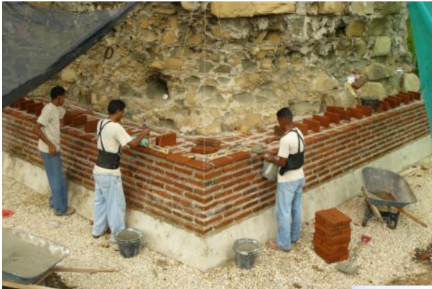
Construcción del contrafuerte, Casas Reales
