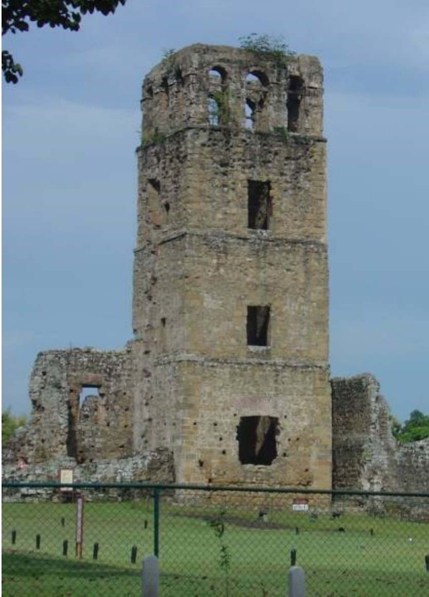
Antes de la consolidación
